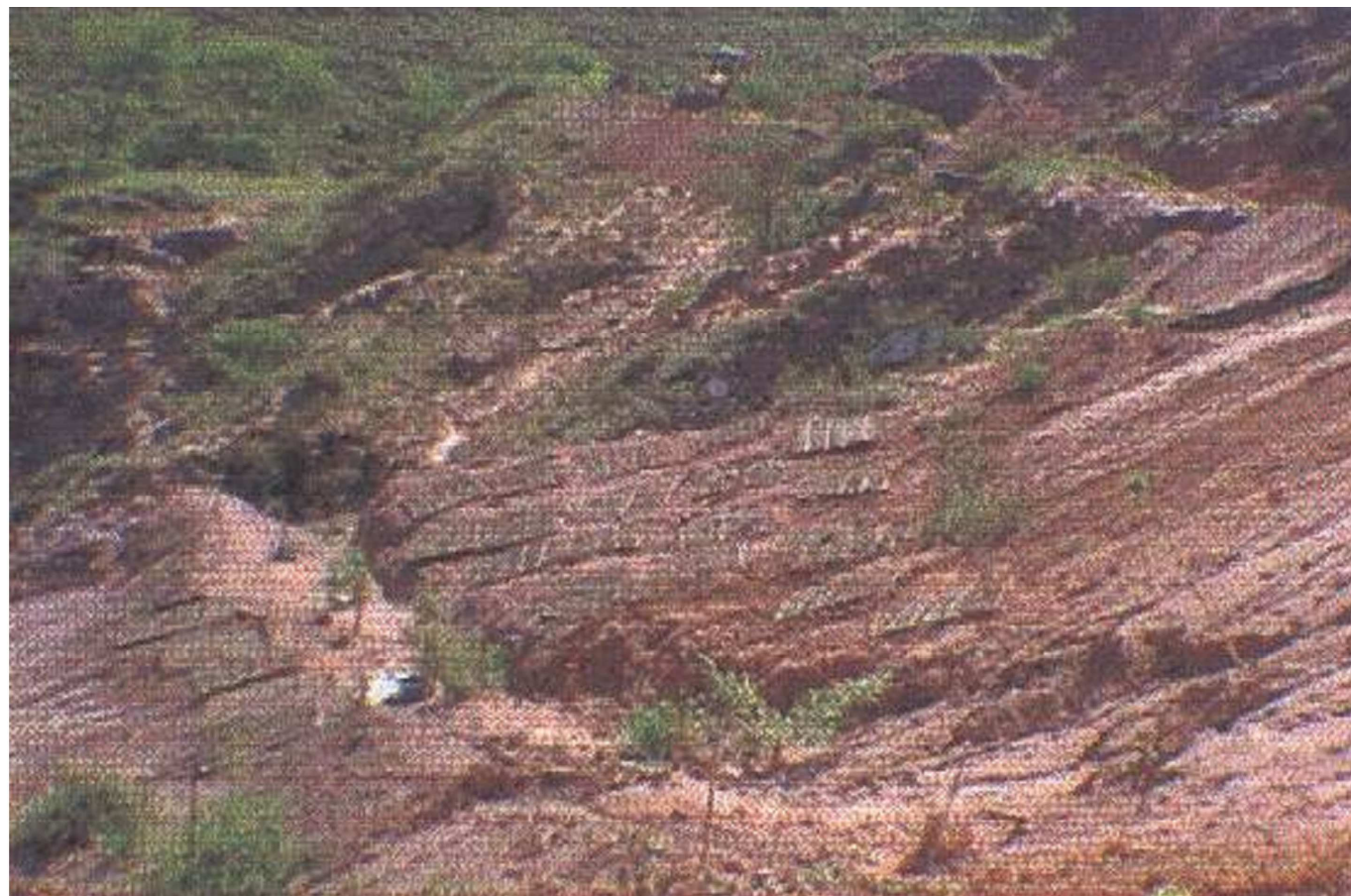
APLICAÇÃO DE MANTA VEGETAL MORTA SOBRE OS TALUDES
