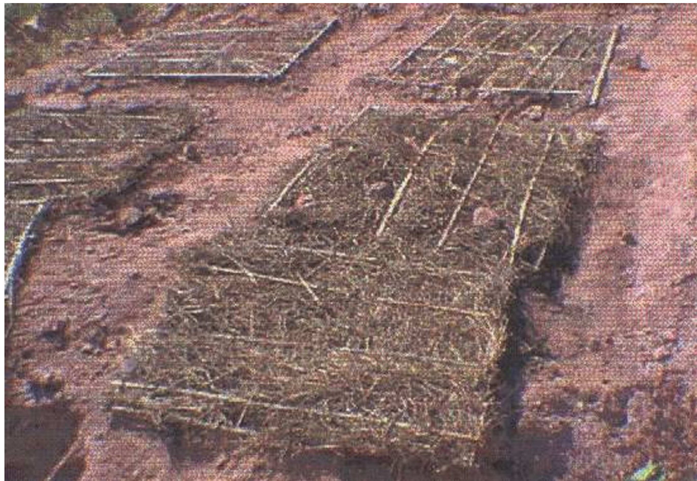
APLICAÇÃO DE MANTA VEGETAL MORTA SOBRE OS TALUDES
